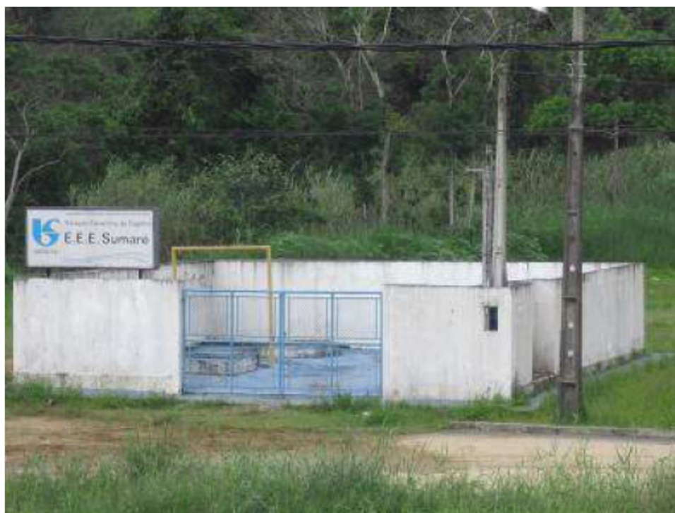
Foto 7 – EEE Sumaré – Sistema Principal
